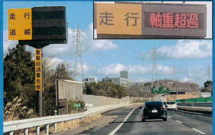
高速道路本線での「軸重超過」表示
